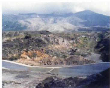
工事中の埋設型治山ダム(平成2年)
