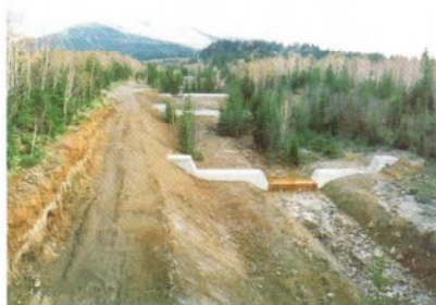
硫黄沢治山ダム[床固工](平成4年施工)
