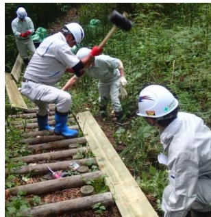
木製階段の修繕
