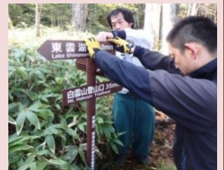
誘導標識の設置
