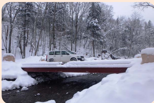
設置した仮設橋（清水谷林道）
