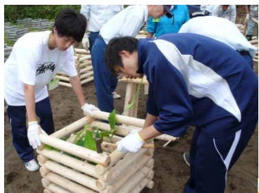
木製フェンスの組み立て
