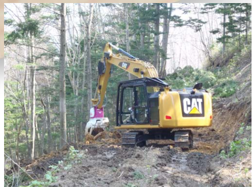
ザウルスロボによる森林作業道作設の状況
