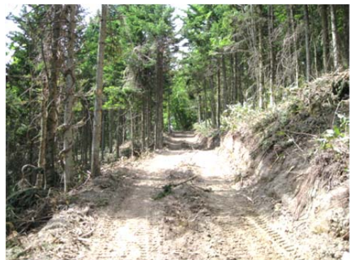
森林作業道作設後の状況
