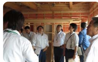
建築物の構造見学会等により建築事業者や施主等のエンドユーザーのニーズ把握。
