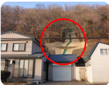
(平成 25 年 12 月工事完成時)
