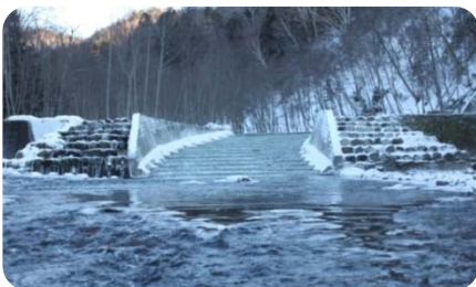
中央部を改良し、階段状の魚道を設置しています。
