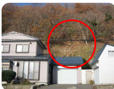
(平成28年4月完成後2年経過)
