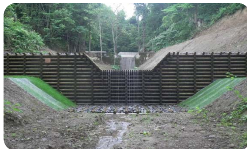
北海道森林管理局長賞「法導寺の沢治山工事」 (空知署)
