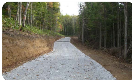
北海道森林管理局長賞 「我妻の沢林道オロエンの沢支線新設工事」 (後志署)
