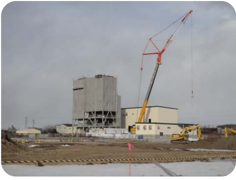
建設が進むバイオマス発電所
