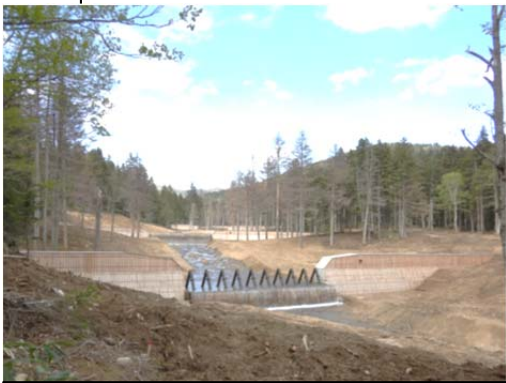
さる ひだか 沙流郡日高町 保全対象 国道274号
