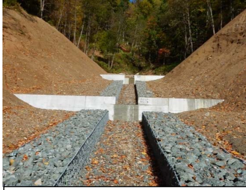
きたみ るべしべ 北見市留辺蘂 保全対象 国道39号
