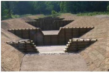
流路工を併用した木製校倉式床固工
