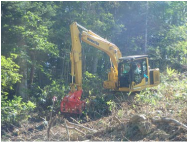
一貫作業システムによる地拵作業 (グラップルレーキ)
