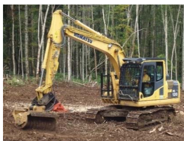
木の枝など破碎するクラッシャーを使用した地拵えとマルチング
