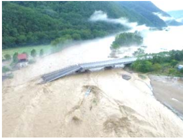
落橋した千呂露橋 (日高町)
