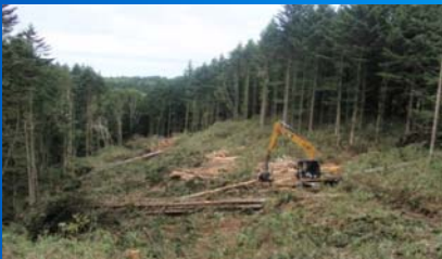
平成24年9月1日 ハーベスタによる造材作業 (伐採幅 33m)
