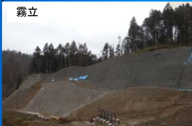
平成24年度施工の災害復旧工事箇所
