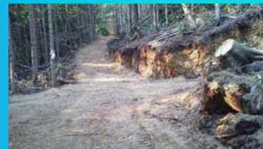
ミニバックホウ0.20m 3 で作設した森林作業道 6月29日上川南部署
