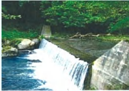
改良前: 段差が高くサケ類の遡上が難しい状態です。
