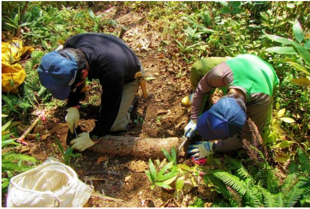
<近自然工法による登山道補修状況>
