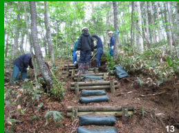
土のうの設置
