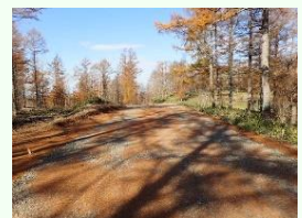
⑤ 路盤工 完了後
