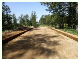
② 路床内法仕上げ 完了後
