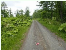
① 施工前 既設林道
