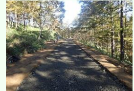
④ 砕石舗装工 施工後
