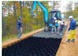
② 充填材敷き均し
