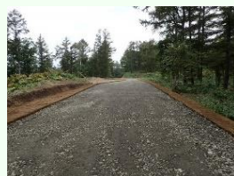
③ 路盤工(下層路盤20cm) 転圧作業 完了後
