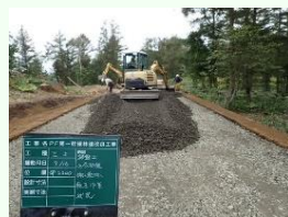
④ 路盤工(上層路盤10cm) 敷均し・転圧作業 施工中
