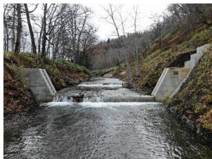
令和3年度施工 治山施設の改良
