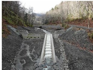
令和4年度施工 張り出し式魚道
