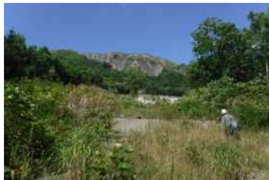
(カスケード(階段滝)状の床固工ダム群で森林へ)
