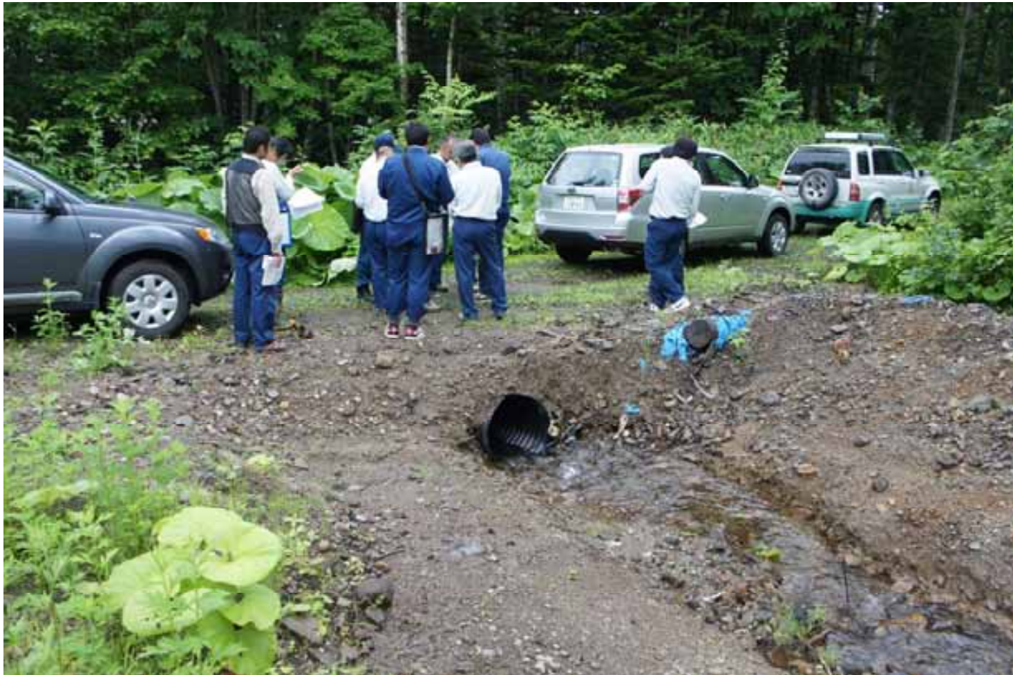
1043 林班イ小班の沢渡り箇所呑口の状況
