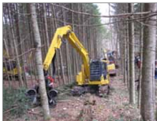
緩傾斜地での作業風景
