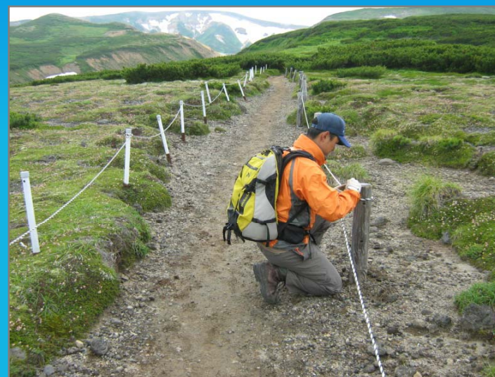
歩道の整備(上川中部森林管理署管内)
