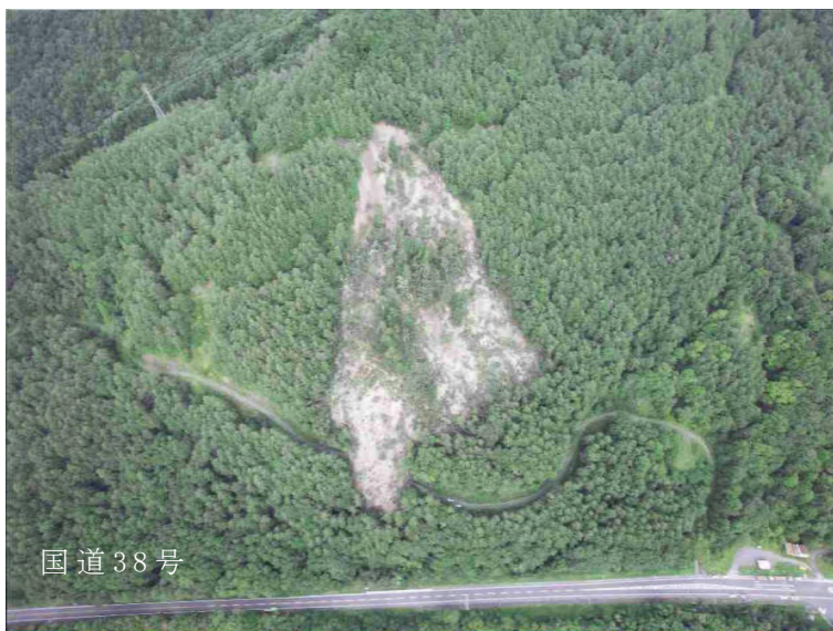
8月22日に発生した芦別市野花南の地すべり災害 (空知森林管理署管内)
