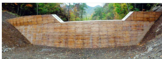
残置式丸太型枠（日高北部森林管理署管内）
