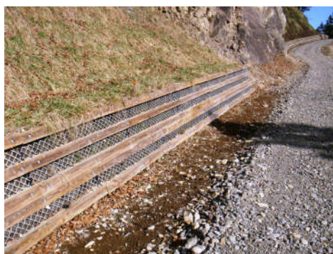
木製土留工（十勝東部森林管理署管内）
