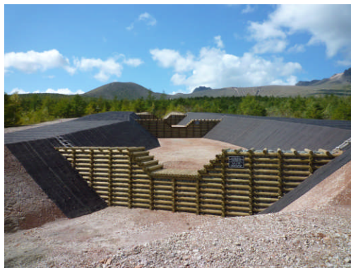
木製の溪間工（渡島森林管理署管内）
