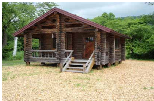
ウッドチップ敷設の様子
