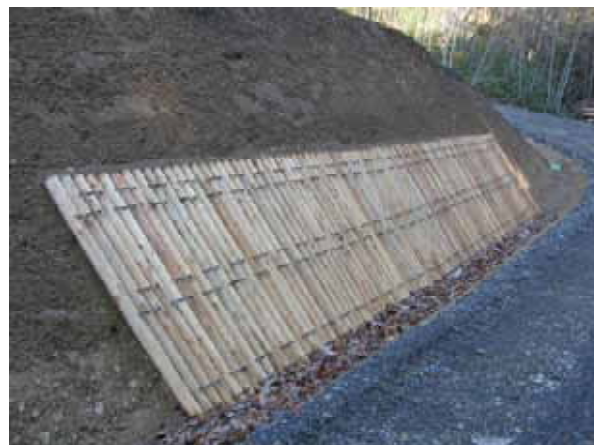
見通しの確保を図るためカラマツの間伐材を使用した林道法面工事
