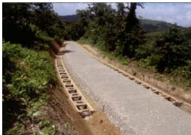
スギ・カラマツの間伐材を使用した木製側溝
