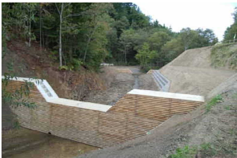
コンクリート型枠に間伐材を使用した治山ダム
