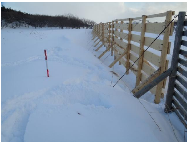
平成 25 年 堆雪状況
