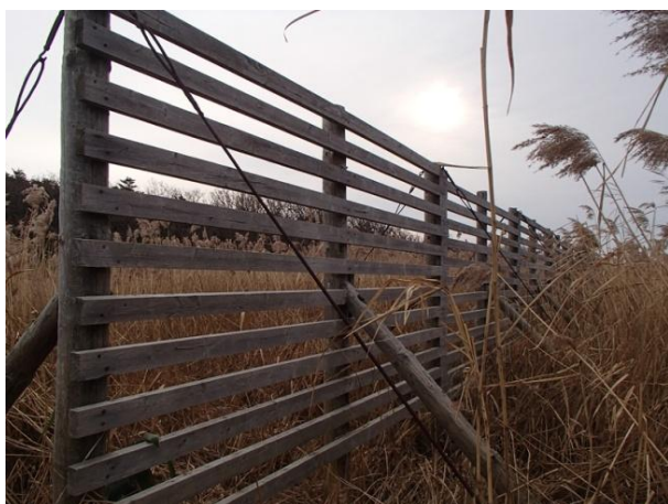
平成 25 年 外見に大きな歪みはない
