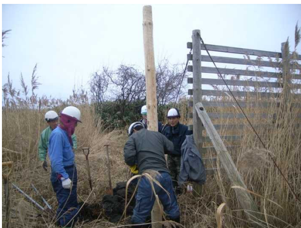
主杭の建て込み
