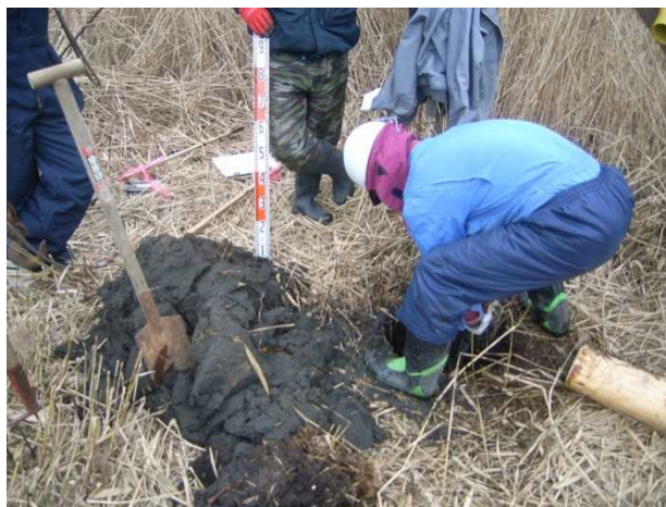
主杭穴 砂層が混じる
