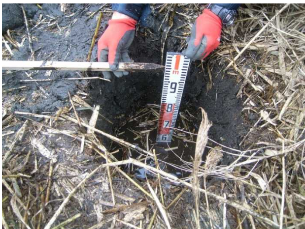
主杭穴 地下水位が高い
