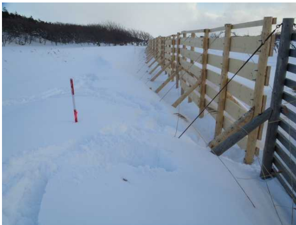
平成 25 年 堆雪状況
