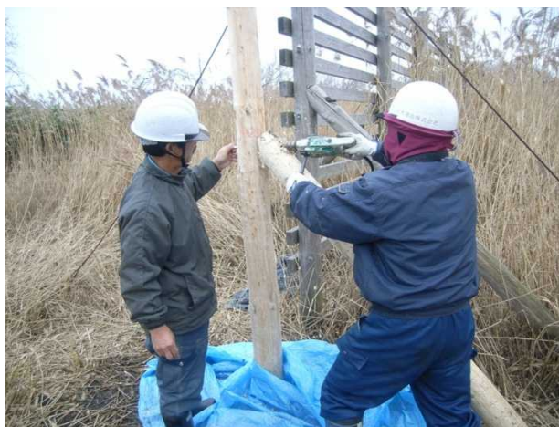
支え杭 ブルーシートによる木屑飛散防止
