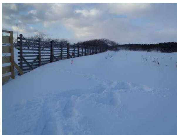
平成 25 年 堆雪状況
