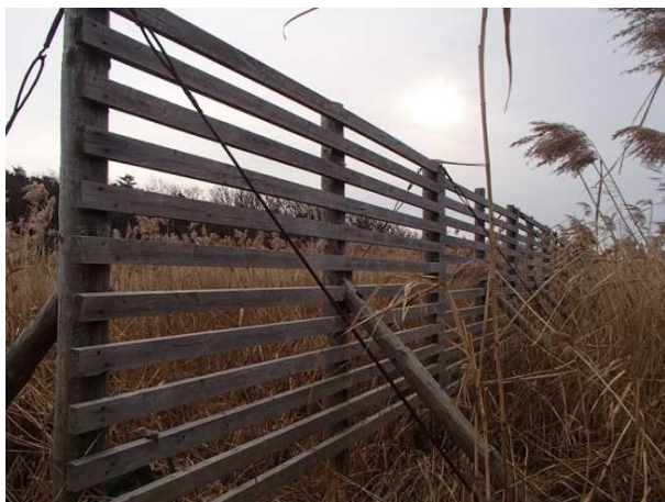
平成 25 年 外見に大きな歪みはない
