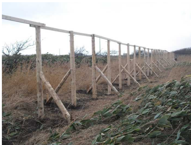
主杭、支え杭、補助杭設置
