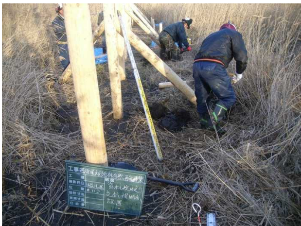
支え杭の建て込み
