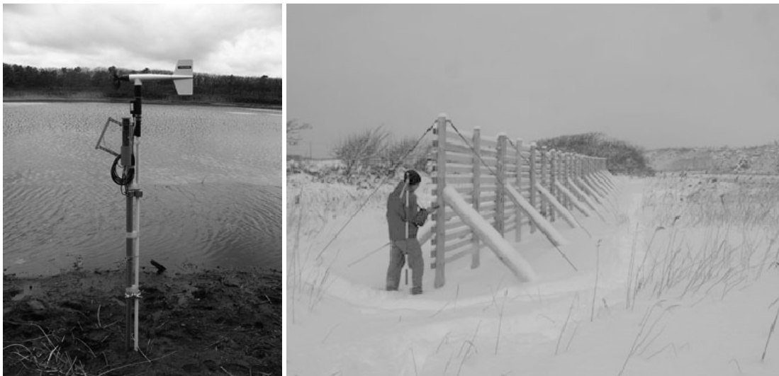
図-8 風向風速計(左)、防風柵(右)の設置状況
