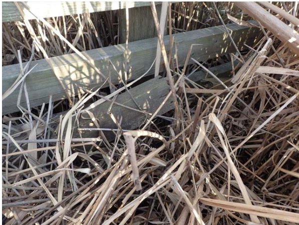
平成 29 年度 沈下による最下部の横板の破損
