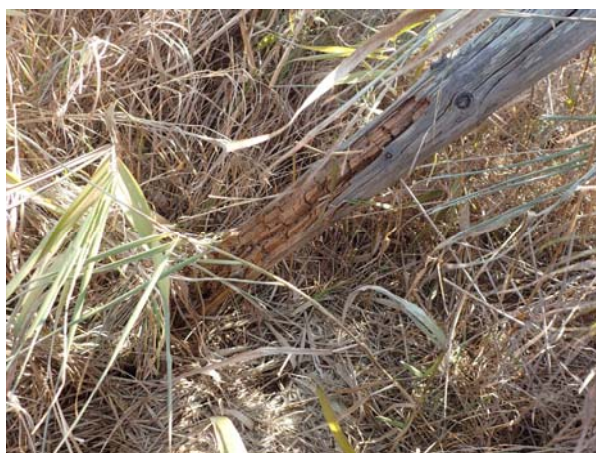
平成 29 年度 斜め支柱の腐れ
