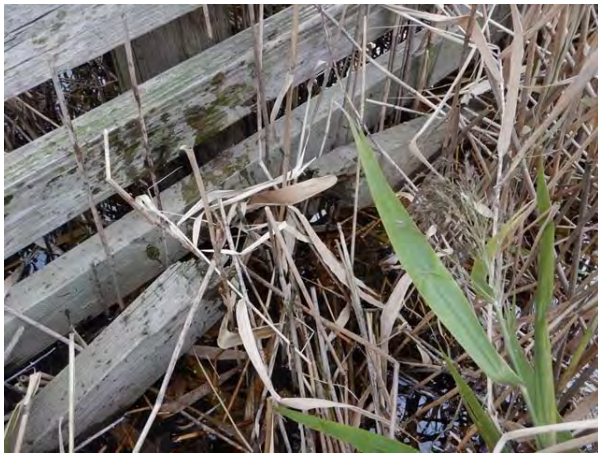
平成 28 年 沈下による最下部の横板の破損
