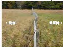
湖沼#119堆雪柵(H20設置)
