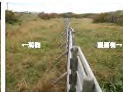
湖沼#112堆雪柵(H25設置)
