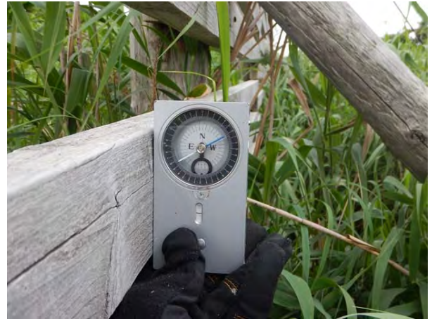
平成 27 年 傾斜状況(1°)
