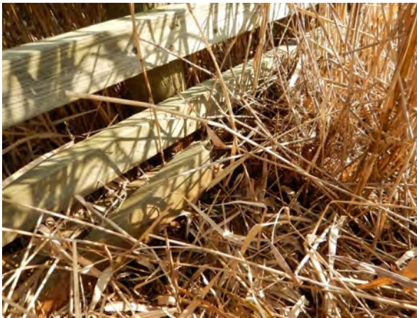
平成 26 年 沈下による最下部の横板の破損
