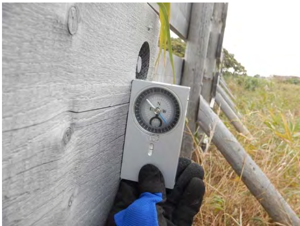
平成 28 年 傾斜状況 (0° )
