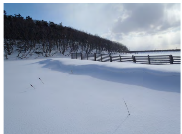
平成 25 年 風下側の堆雪状況
