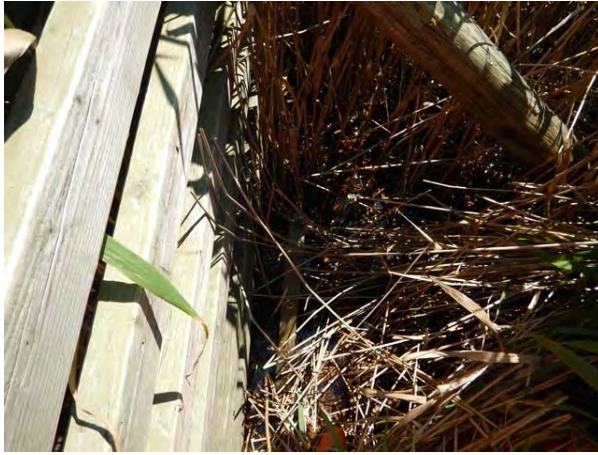
平成 27 年 沈下による最下部の横板の破損
