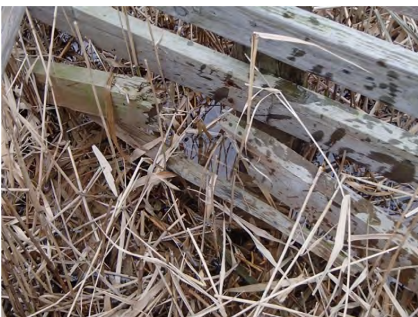
平成 25 年 柵の沈下に伴う横板の破損
