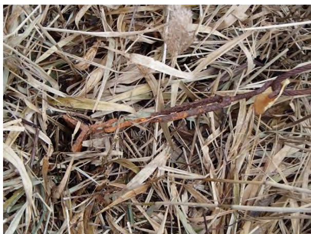
平成 25 年 錆びて腐食しているターンバックル
