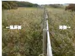
湖沼#112堆雪柵(H20設置)
