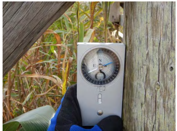
平成 28 年 傾斜状況(1°)
