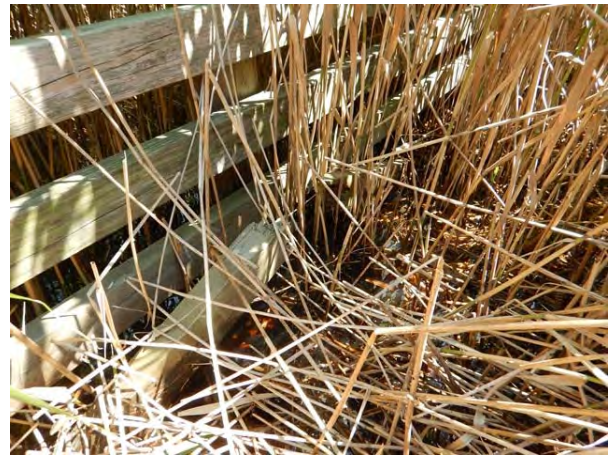
平成 27 年 沈下による最下部の横板の破損
