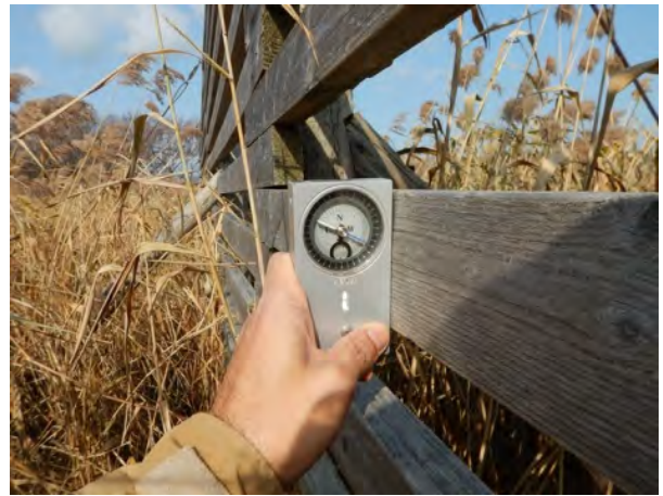
平成 26 年 傾斜状況(1°)
