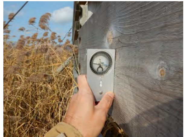
平成 26 年 傾斜状況(1°)
