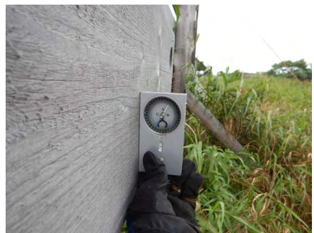
平成 27 年 傾斜状況(1°)
