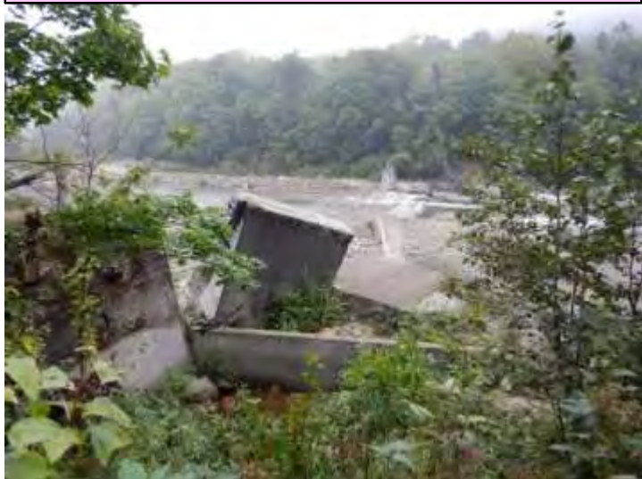
戸蔦別川流域の治山ダムの状況 (309林班オピリネツ沢下流)
