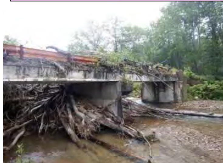
美生川流域の橋梁の状況 (267林班上美生林道清流橋)
