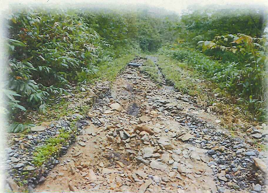
作業道修理(路面整正・敷砂利)
