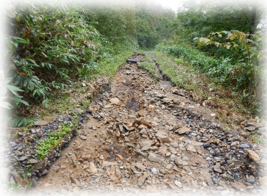
作業道修理(路面整正・敷砂利)
