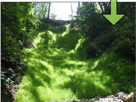
(施工後)山腹緑化工施工箇所
