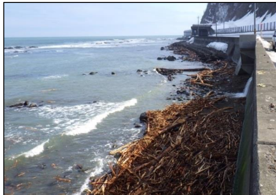
○海岸へ流出した流木
