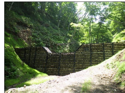
○第5号鋼製柵谷止工
