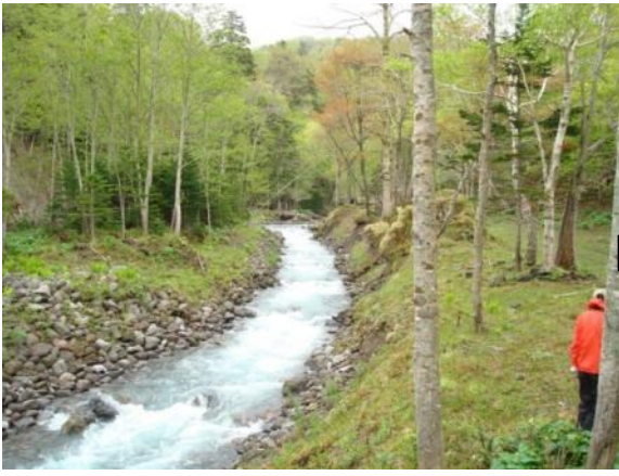
赤イ川No.12 鋼製えん堤上流 (H25/6/5)
