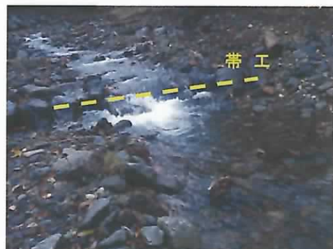
堤体上流区間：巨石連結格子枠による帯工と石張護岸による整備
