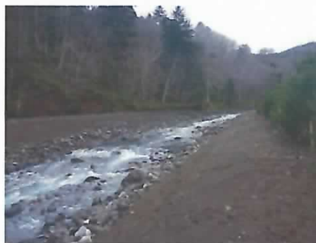
施工直後上流部の流路 (H22 年 11 月)
