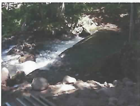
堤体部（改良工事施工前）
