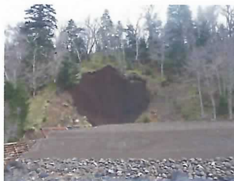
右岸の山腹法面工 (H22 年 10 月)
