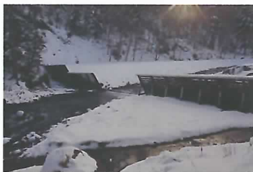
下流左岸に砂州形成 (H22 年 12 月)
