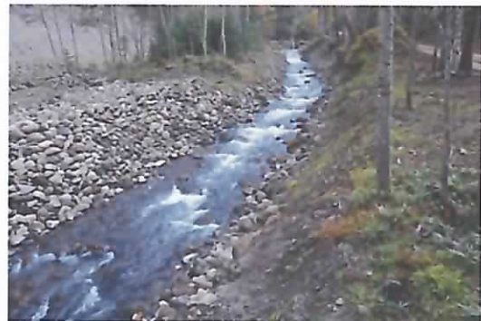
上流側の流路 (H22 年 10 月)
