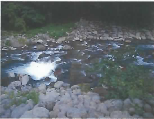
堤体越流部 (左岸より撮影) H21 年 9 月
