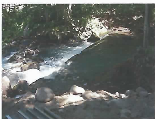
堤体部（改良工事施工時）
