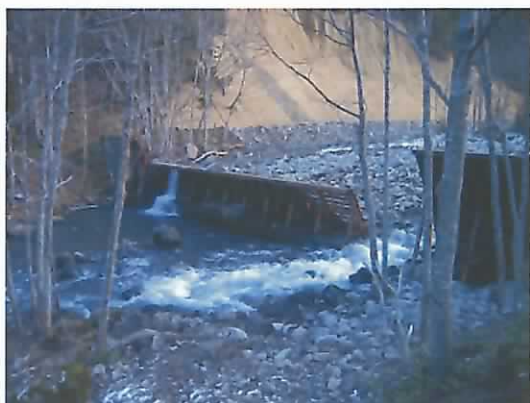
堤体全景（改良後）H21年12月
