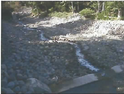
ピリカベツ川 H19改良治山ダム(No.8、No.10) 堤体より上流側を撮影。
