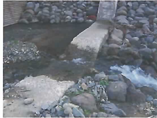
ピリカベツ川 H19改良ダム 副ダム(No.10) 堤体の越流部の状況。
