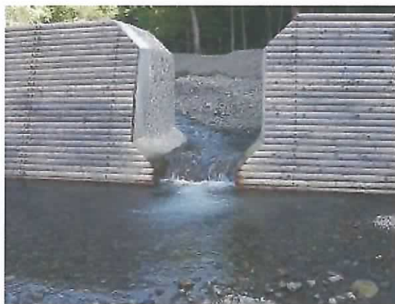
写真 4-4 改良箇所スリット部 (No. 8)
