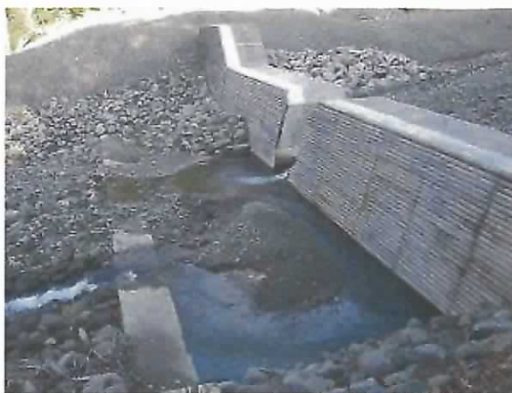
写真 4-5 スリット部下流側の状況 (No. 8, No. 10)
