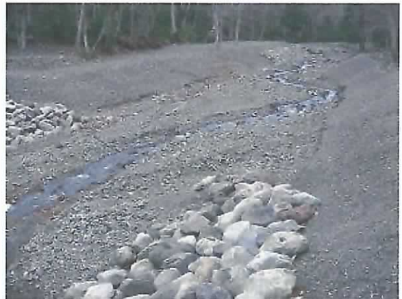
(堤体部より上流の状況)
