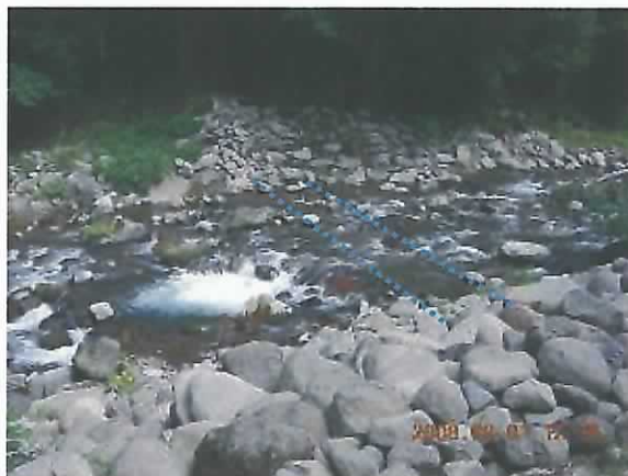
写真 3-6 赤イ川 No.11 治山ダムの状況
