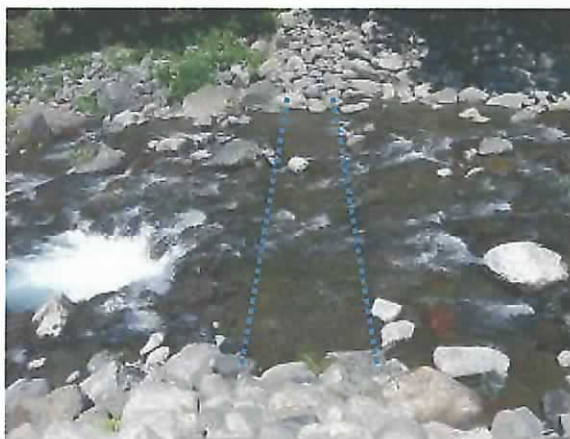
写真 3-7 越流部の状況
