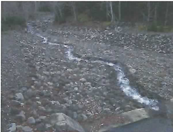
(堤体部より下流の状況)
