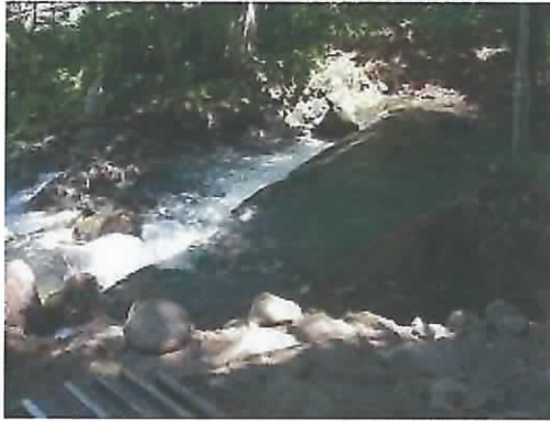
堤体部 (改良工事施工時)
