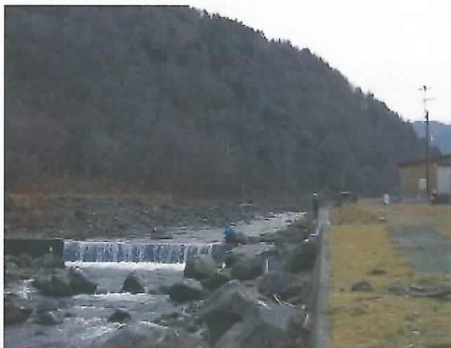
写真 2-3 さけ・ます孵化場の捕獲用えん堤
