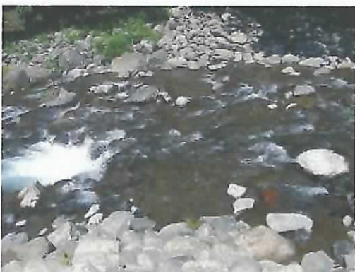
堤体越流部（左岸より撮影）
