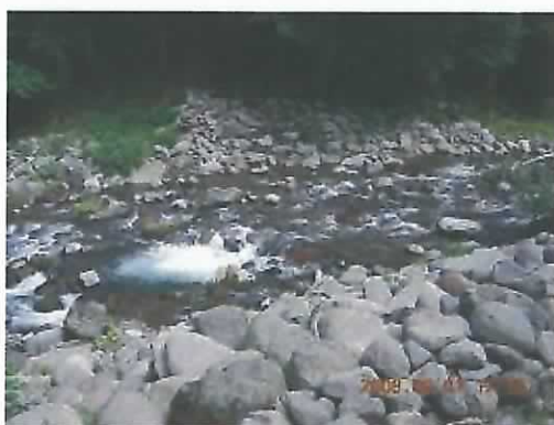
堤体全景（左岸より撮影）
