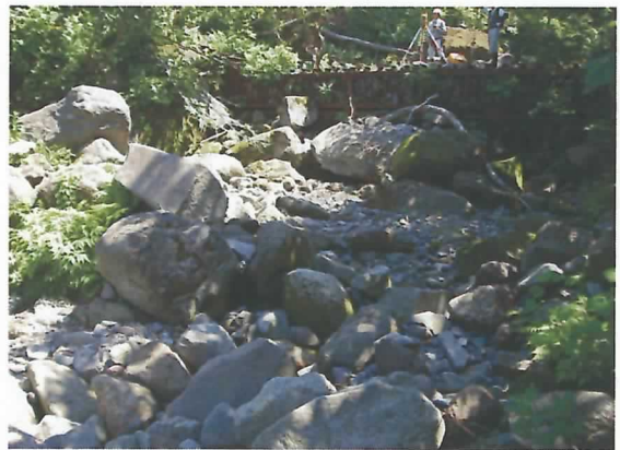
上流の土砂堆砂状況。
