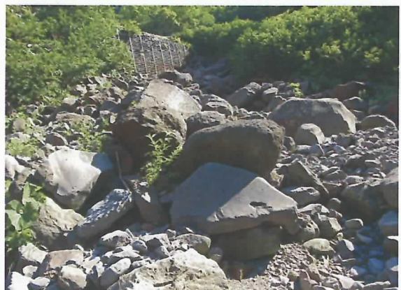
上流の土砂堆砂状況。
