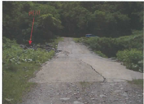
上流の状況(河床路あり)。
