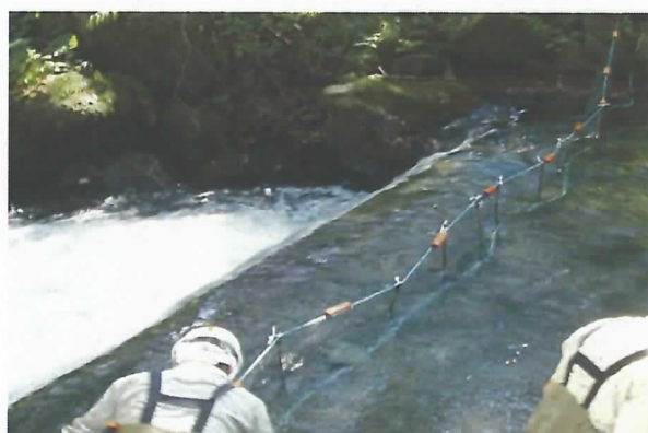
④斜里町（導水管）上流への降下防止ネットの設置
