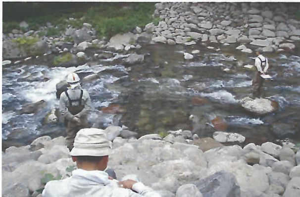
⑮改良治山ダム上での遡上観察
