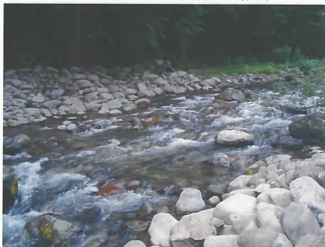
写 6-2-2 定点より対岸部 (改良工作物)
