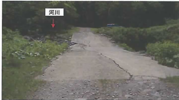
河床路の状況（工作物 No4 の堤体上流部）
