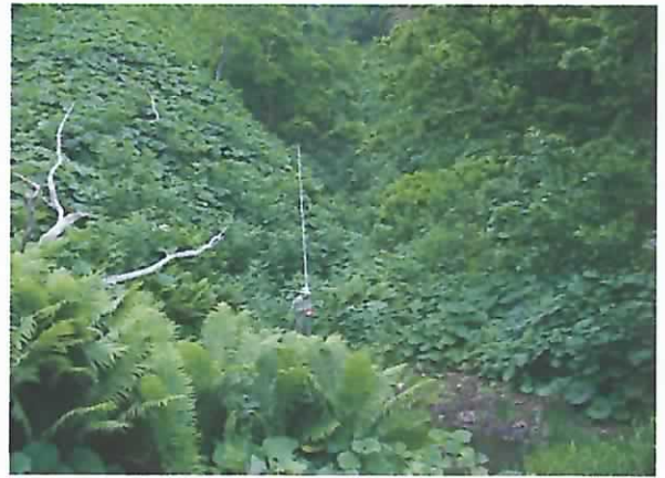
上流の土砂堆砂状況。
