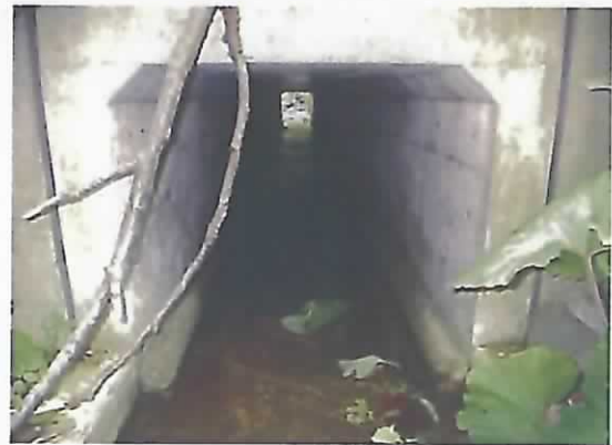
ボックスカルバート内の状況。
