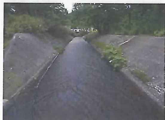
三面張水路工内の状況。
