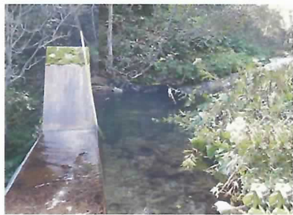
上流の土砂堆砂状況。
