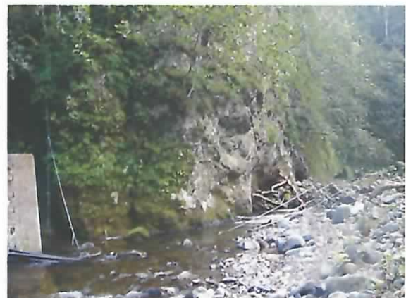
上流の土砂堆積状況。
