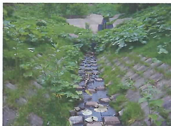
上流のブロック三面張り水路工の状況。
