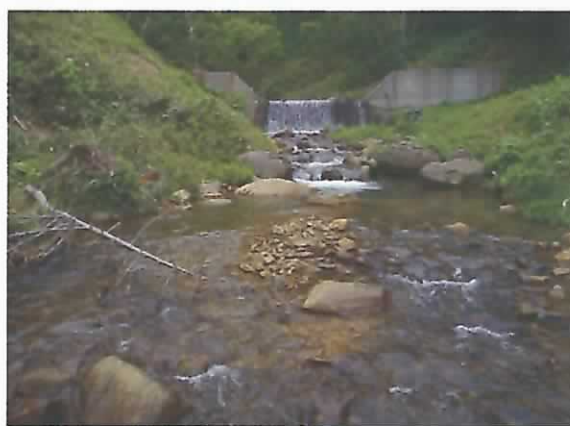
上流の土砂堆砂状況。
