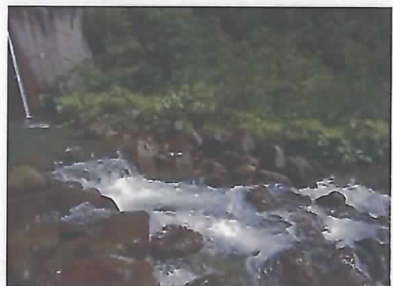
上流の土砂堆砂状況。
