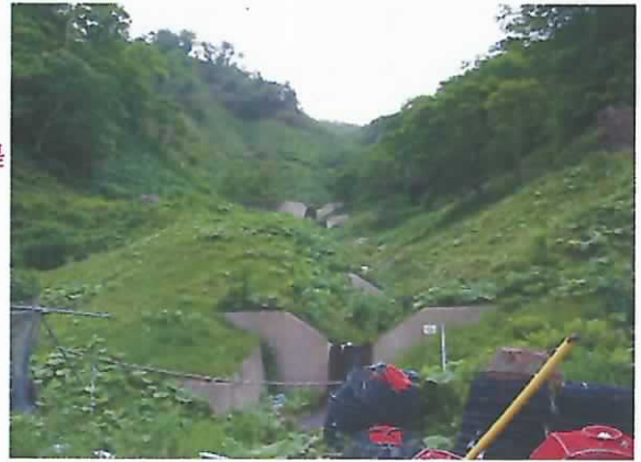
落差工の全体配置状況。
