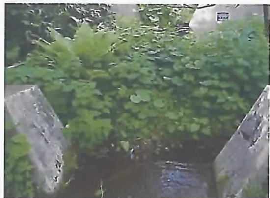
上流の土砂堆砂状況。
