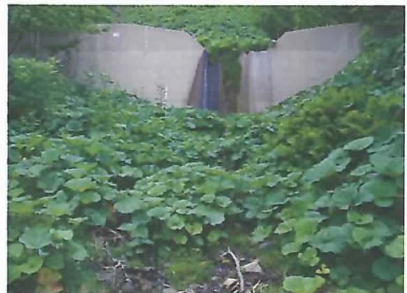
上流の土砂堆砂状況。
