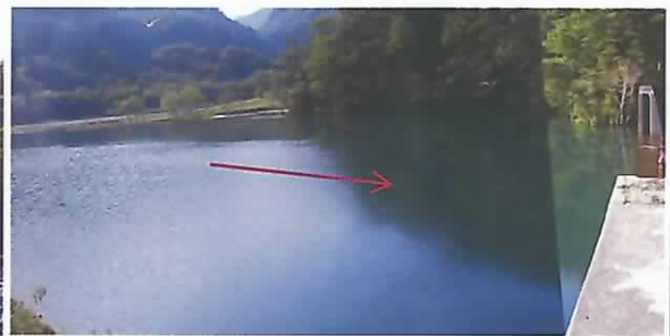
上流の土砂堆積状況。
