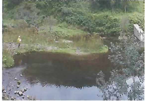
上流の土砂堆砂状況。
