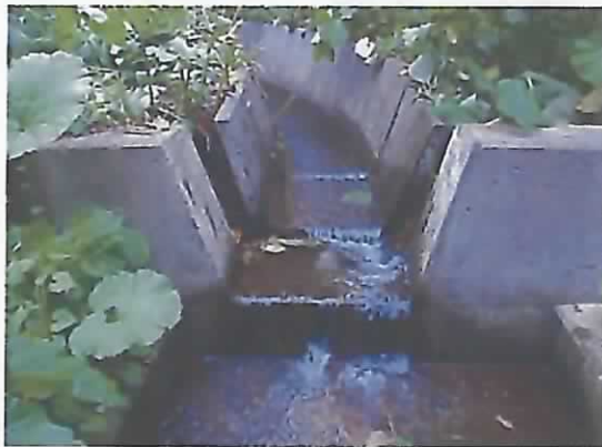
水路工起点の落差工(落差0.25m)。
