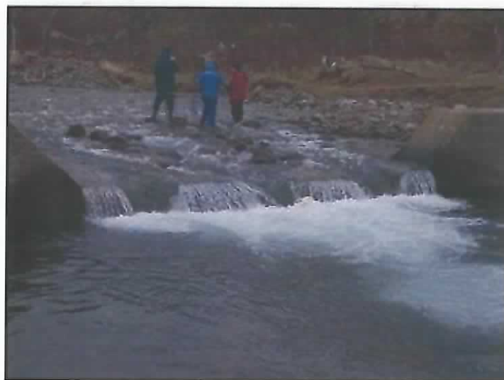
No.2 床固工（ルシャ川）
