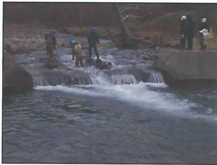
No.1 床固工（ルシャ川）
